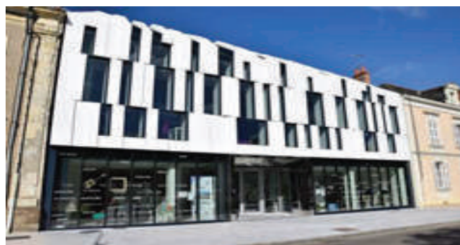
Médiathèque de Château-Gontier © Ouest-France
